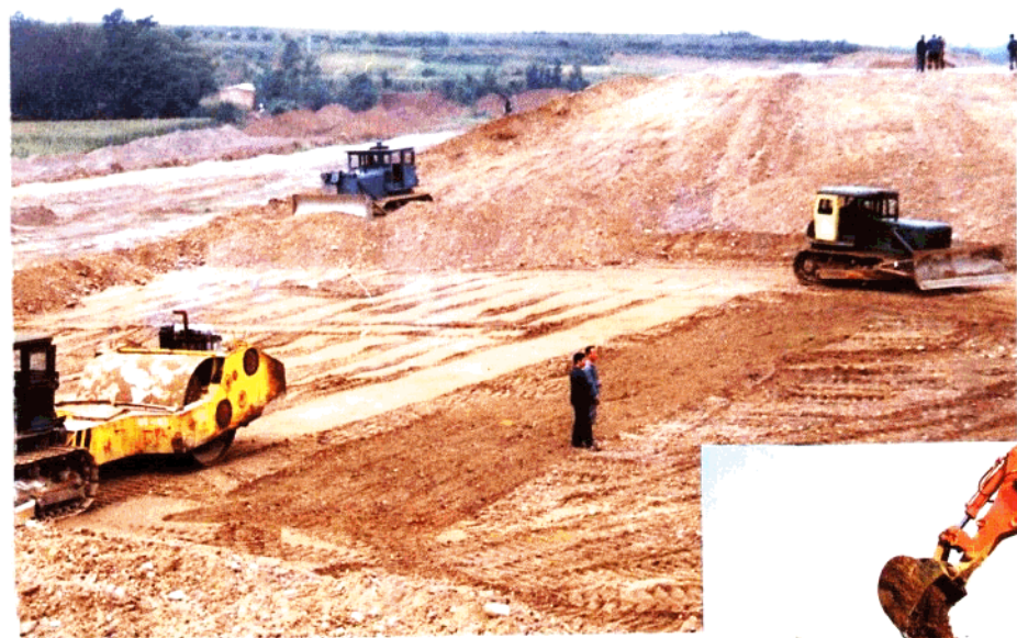
土坝机械化施工
