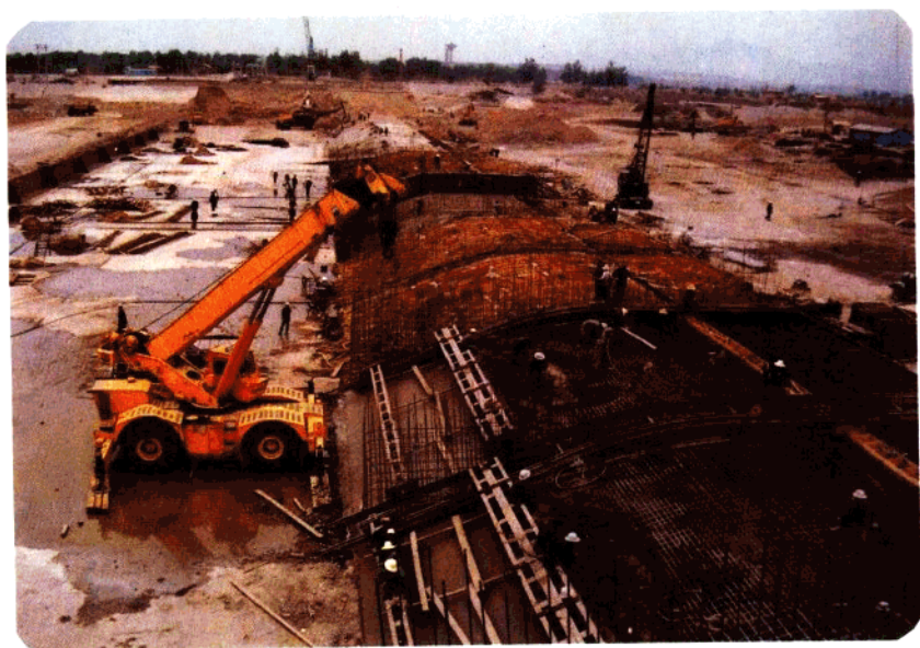
混凝土工程滑模施工
