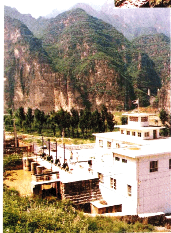
拒马河上的农村小水电站
