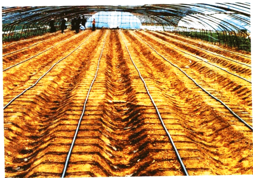
大棚蔬菜微灌管路安装试水
