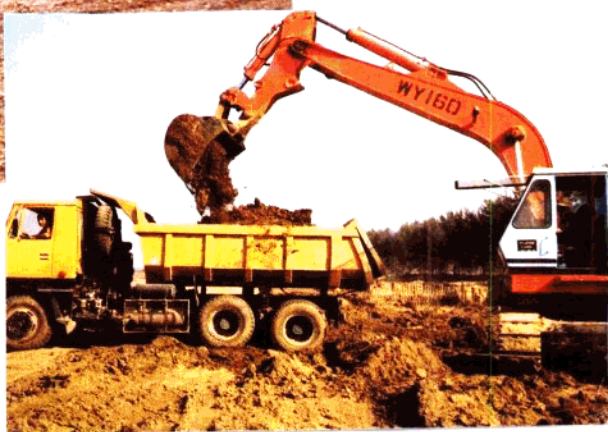
土坝机械化施工
