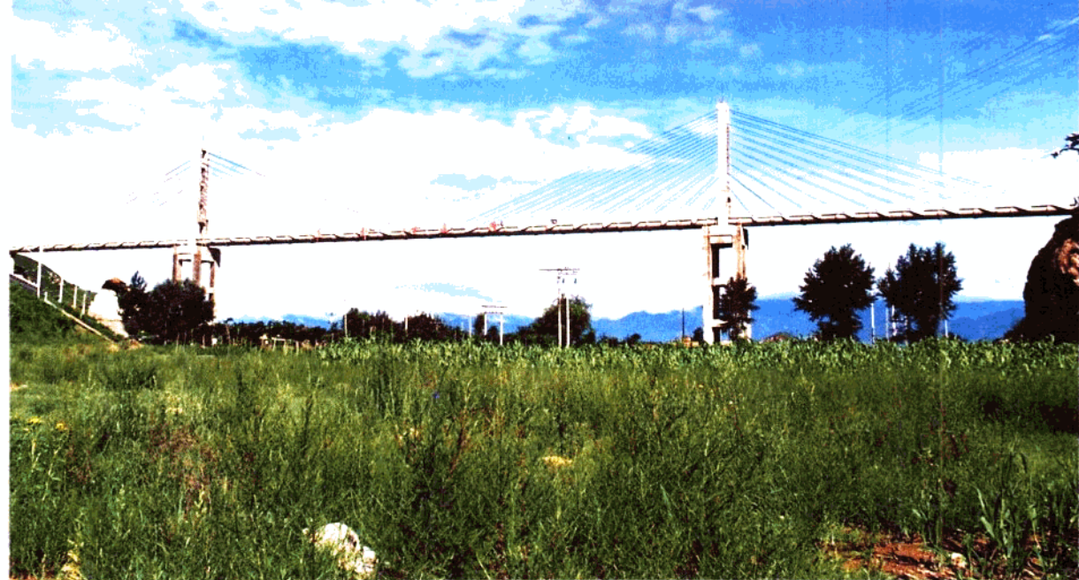
输水渠道上的大跨度军都山斜拉渡槽
