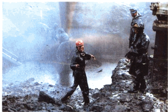
中国灭火队员在油雨浇身,随时都有复燃的情况下,拆掉旧井口,安装新井口。
