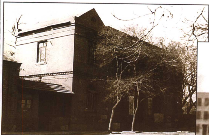
1950年中央气象台办公楼旧址（北京西郊动物园旁畅观楼旧景）
