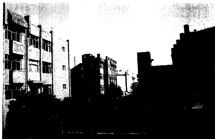
从西往东看连廊、健身房、综合楼
