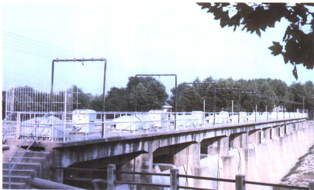
淮河重要的水利工程王家坝闸
