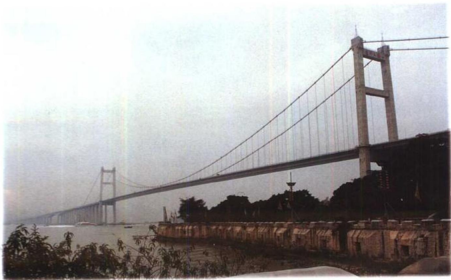
广东虎门现代化特大桥，其主跨888米悬索桥、270米跨经、连续刚构桥、长度分别为目前“全国之最”和“世界之最”。
