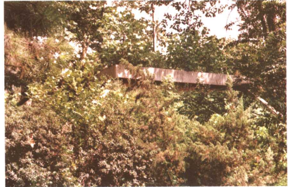
彩图 8-14 西安建筑科技大学掩土太阳房屋顶及周围绿化
