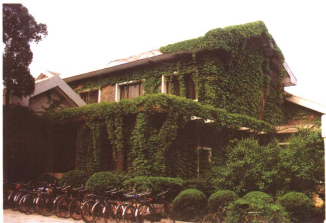
彩图 8-32 北京大学一教学楼墙面及屋顶绿化
