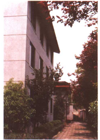
彩图 8-18 嘉定宾馆散水绿化(采用自由落水)
