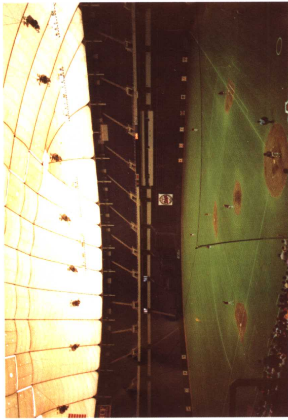
彩图 5-18 [美] 大跨充气薄膜自然采光屋顶
