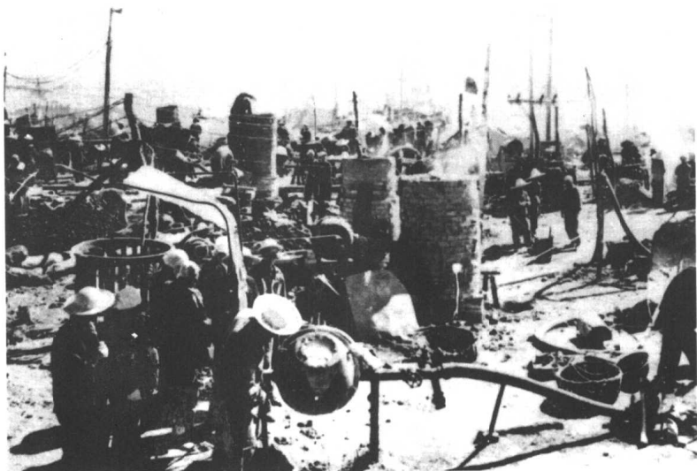
1958 年，北戴河会议号召全党全民为生产 1070 万吨钢而奋斗，全国掀起空前规模的全民大炼钢铁运动。图为山西故县农民的小土高炉炼钢一角，炼出的都是含杂质很高、无用的废“铁蛋”，造成资源极大浪费。
