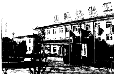
包头黄化化工股份有限公司办公楼
