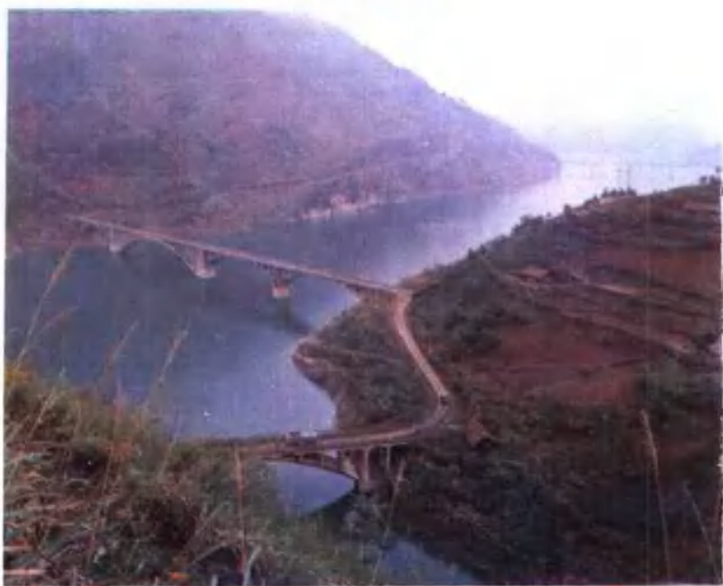
湘西罗依溪公路大桥
