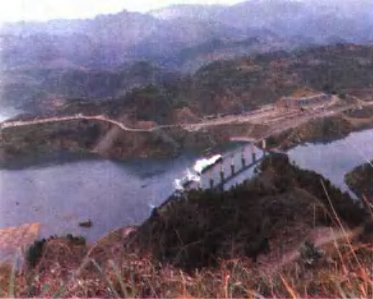
湘西罗依溪铁路大桥
