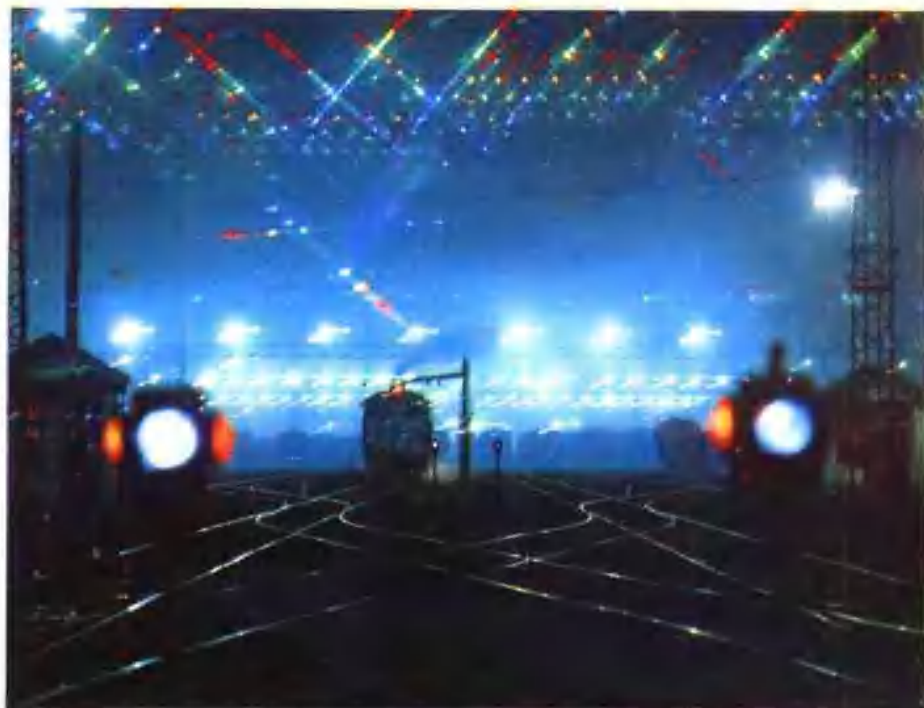
铁路枢纽——株洲北站编组场
