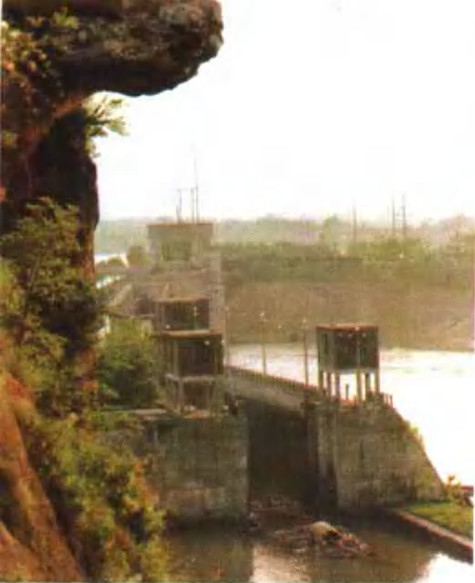
航道船闸工程
