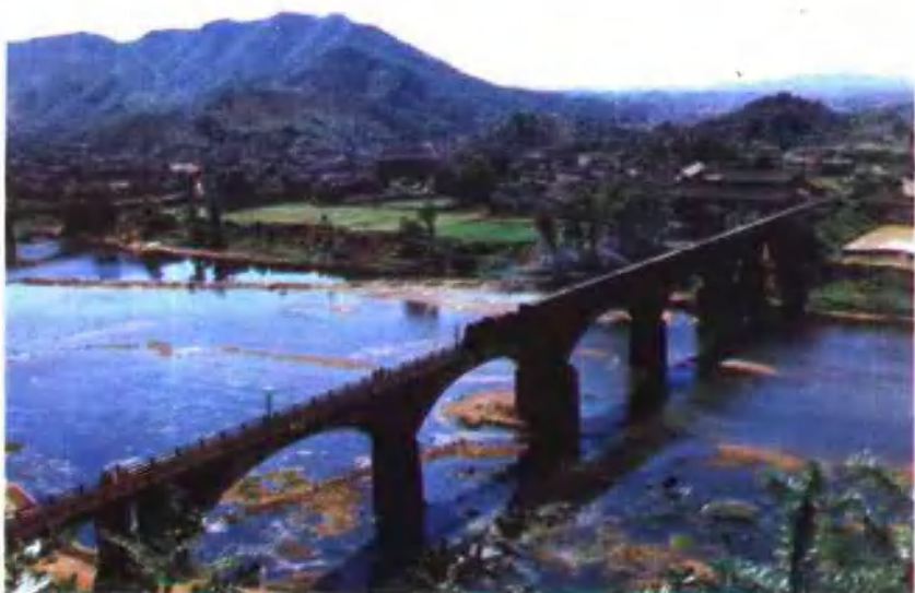
醴(陵)浏(阳)窄轨铁路桥
