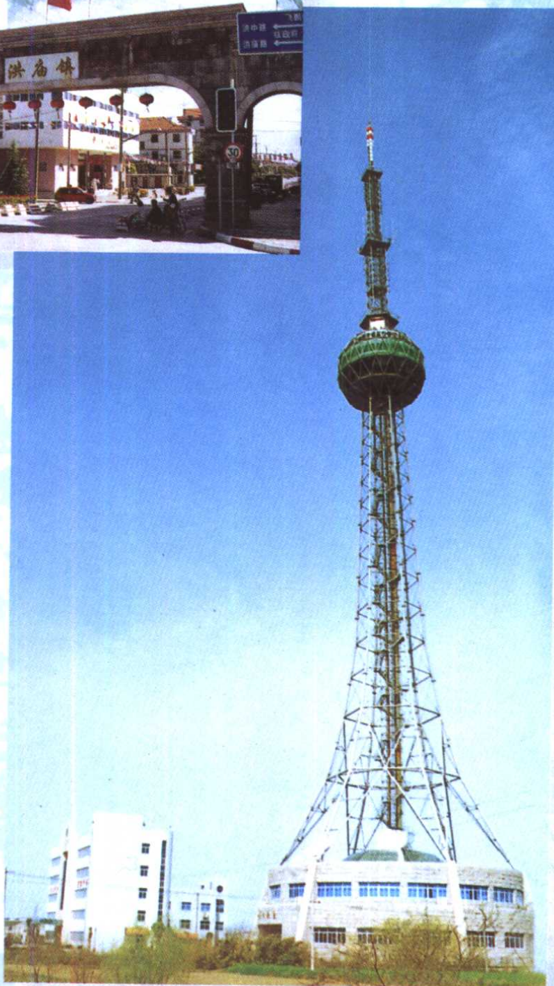
▷ 奉贤电视台电 视发射塔
