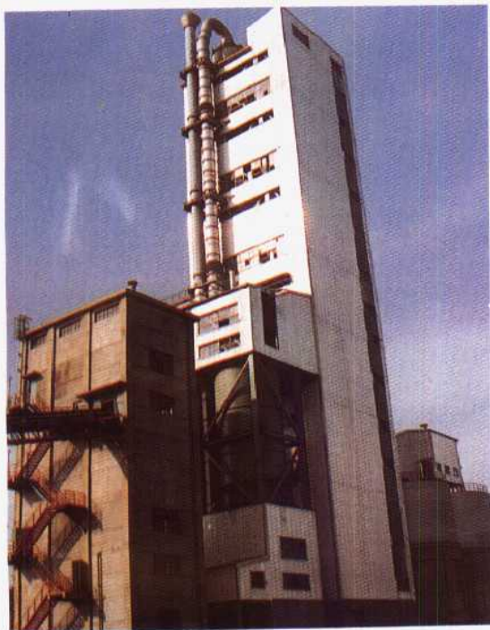
▽ 冶金部鞍山焦化耐火材料設計研究院設計的 國內首創懸浮窯煅燒活期石灰裝置
