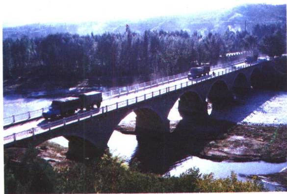
309 国道上的沁河大桥
