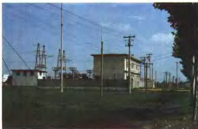
◀ 浦东供电所小湾变电站
