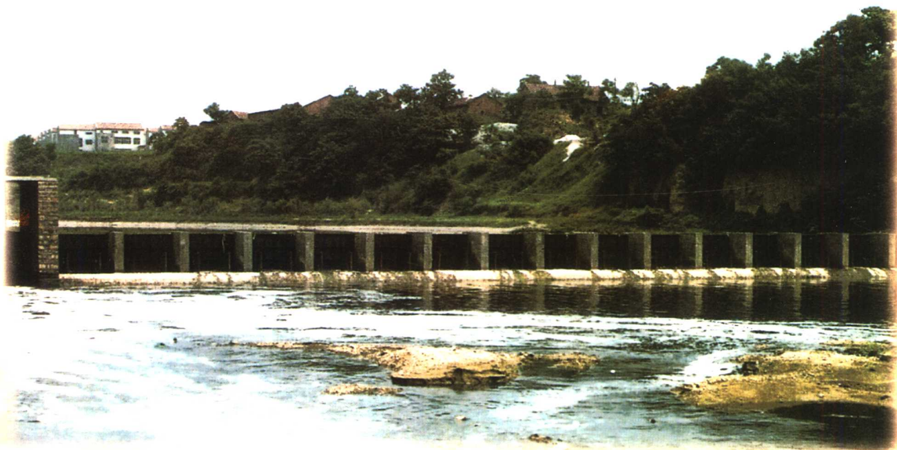
新郑市大型自动翻门闸工程
