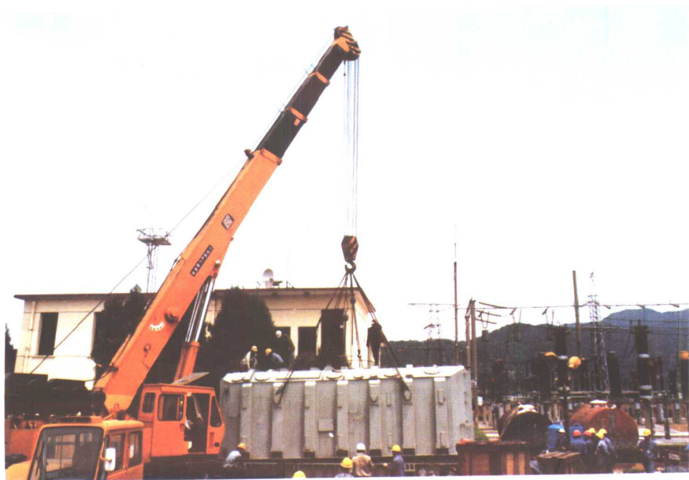
30 220千伏福州东郊变电站12万千伏安主变压器安装
