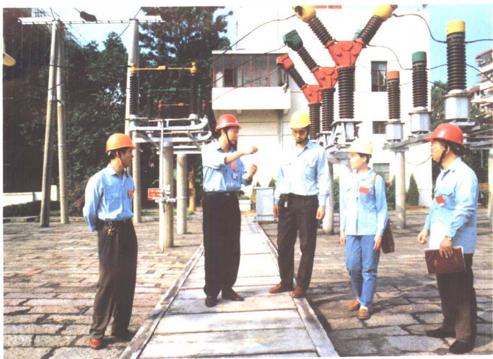
29 福州电业局局长赵义亮(左二)在变电站检修现场
