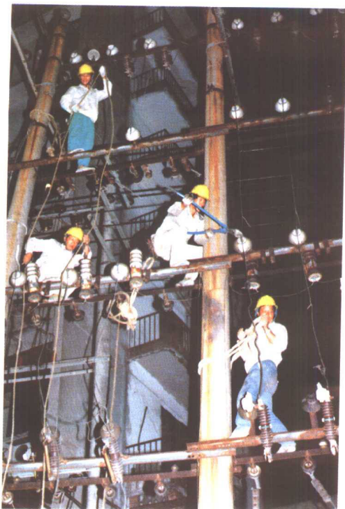
31 变电站检修之一
