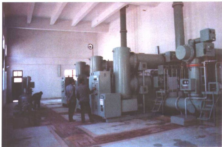
23 110 千伏福州 五四变电站 —— 110 千伏 \text{SF}_6 组合开关
