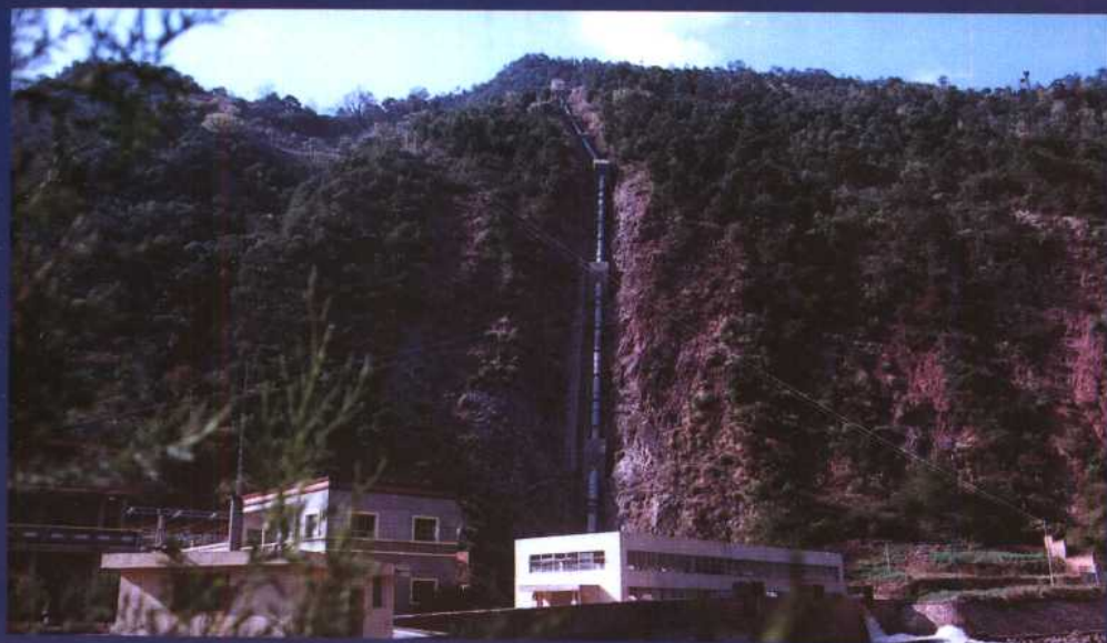
● 武定大响水电站
