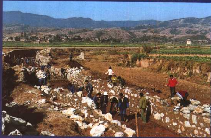
● 坝区改河工程
