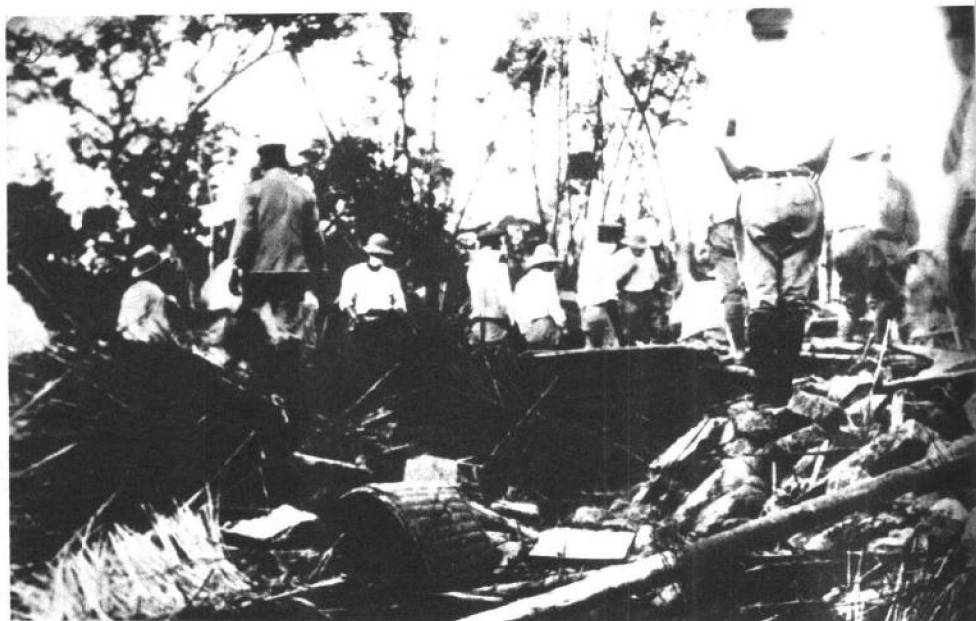
▲1935年4月21日,台湾发生有史以来最大的一次地震,造成3000多人死亡。图为台湾新竹地震灾区。
