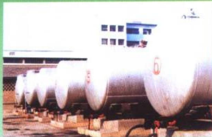
甘肃省化工轻工材料总公司 化工液体配送一角
