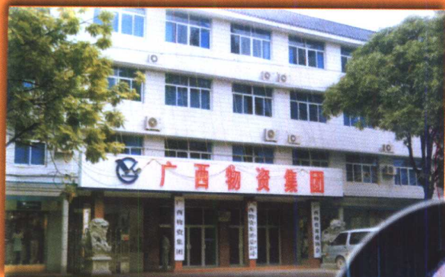
广西物资集团总公司总部大楼
