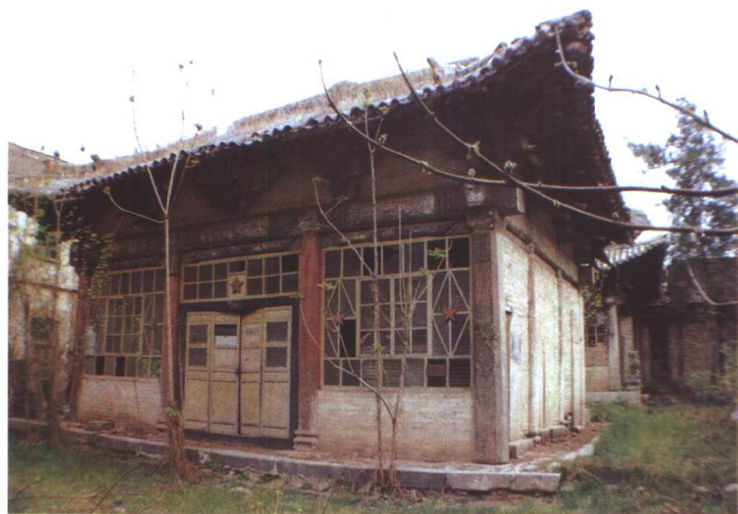
图 2 山西阳城县下 交村成汤庙献 殿(金代舞楼)
