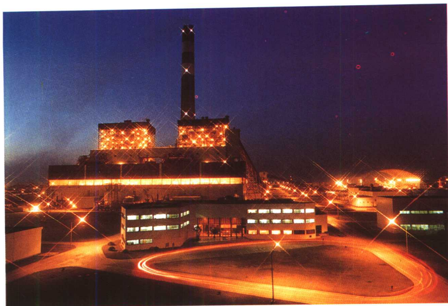
华能上海石洞口第二电厂
