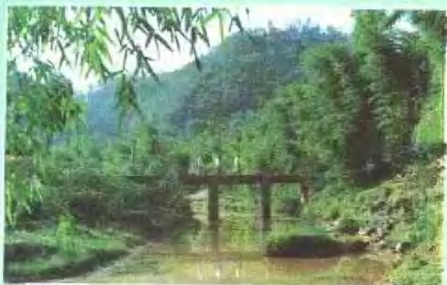
▼ 农村小溪旱桥
