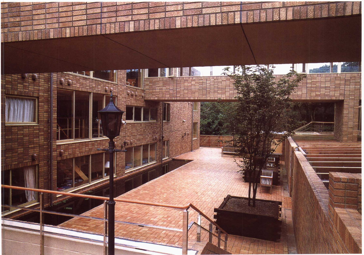
带水池的庭院，建筑物由两条空中走廊连接
