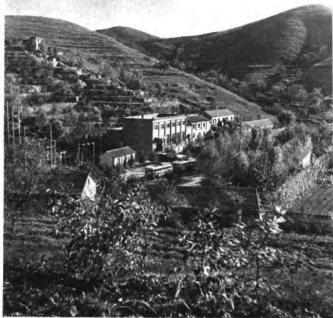
照片 11 红旗渠分水岭水电站
