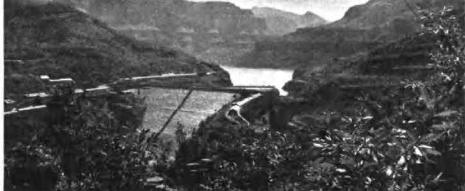
照片 6 南谷洞水库
