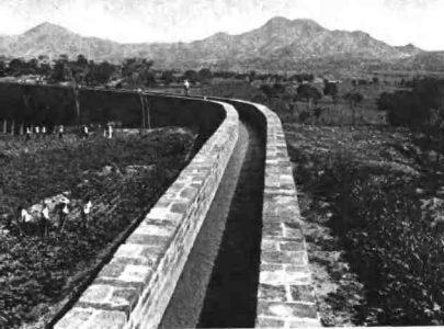
照片 12 夺丰渡槽
