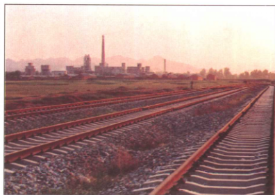
京原铁路从紫荆关通过, 高易铁路经县城通往中高村, 图为易县站外景。
