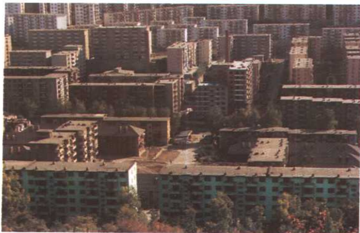
▼ 建工街居民住宅新區
