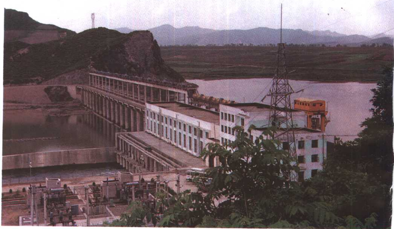
▲ 新建的桓仁鳳鳴水電站
