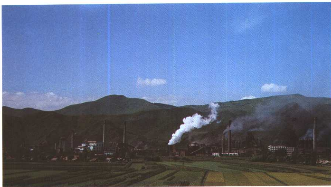
◀ 北台鋼鐵總廠全景
