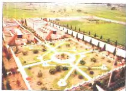
供水公司供水工程
