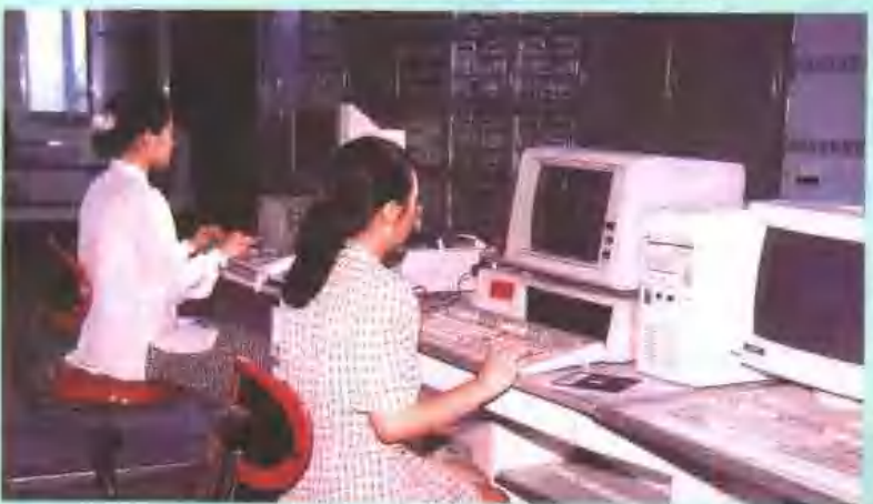
岳阳市邮电局电信分组交换中心
