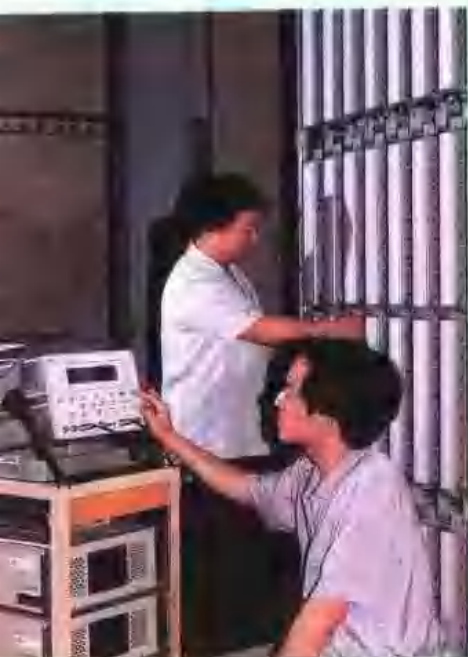
岳阳市邮电局长途电话传输检测中心 岳阳市邮电局移动电话机房工作人员 在装数据磁带(右上)
