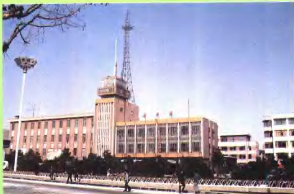
岳阳市邮电局电信大楼
