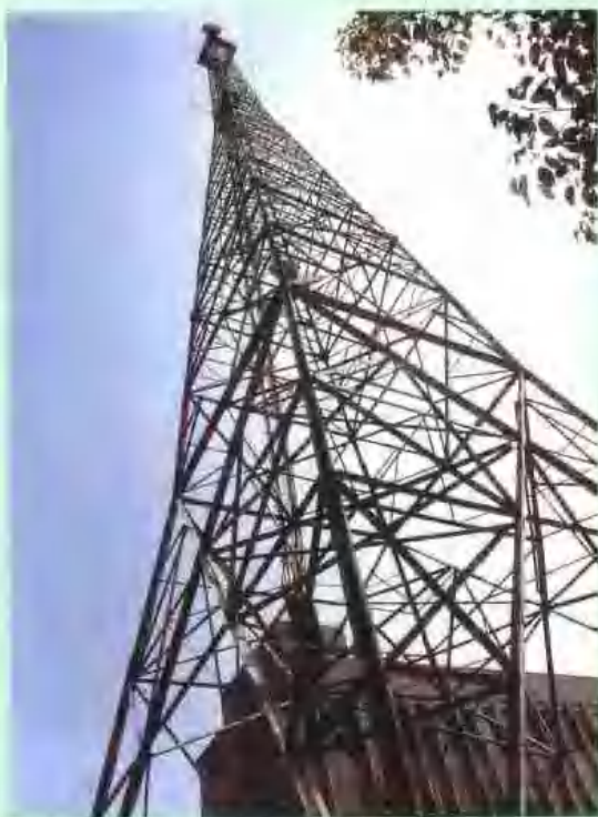
全国最高的微波通信铁塔—岳阳县 微波铁塔(115米)
