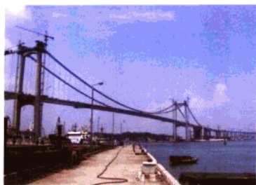
由厦门市气象局承担防雷工程的海沧大桥
