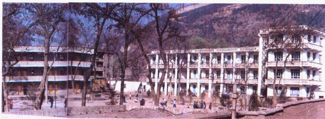
▲ 赫章城关一小危房改造后学校全貌。
