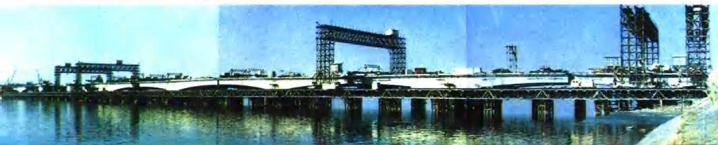
1991年竣工的钱江二桥建设中的雄姿
