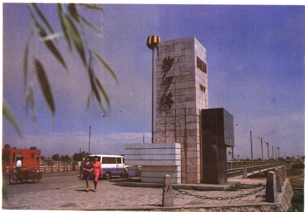
▷ 鞍山市區北出口沙河橋
