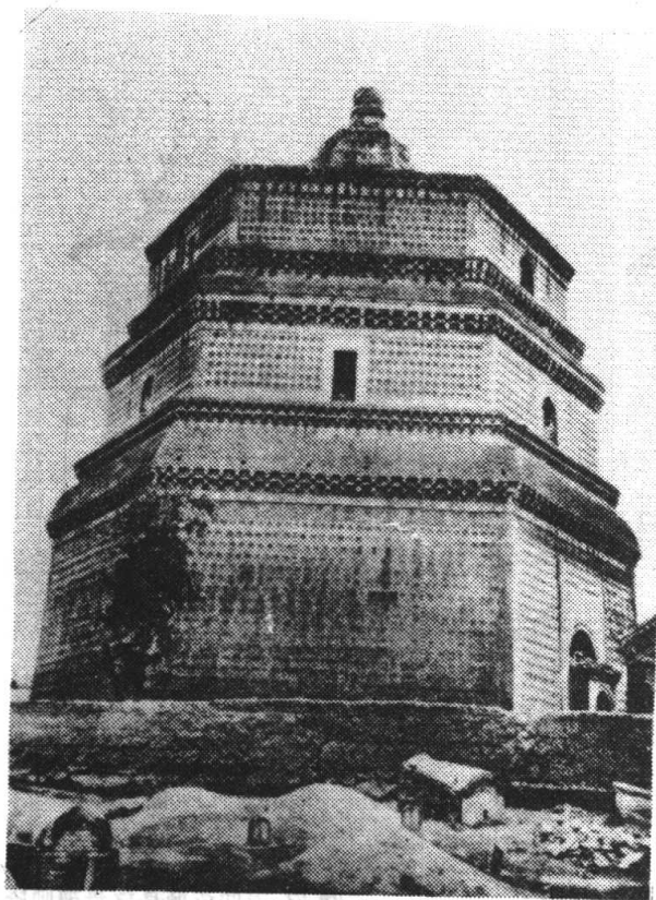
图十 河南开封天清寺繁(Pó)塔
