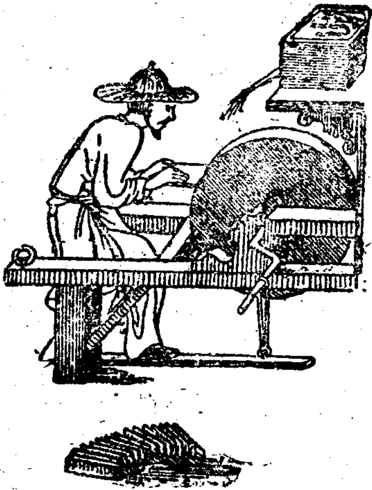
图3 1668年中国的刀具磨床。
