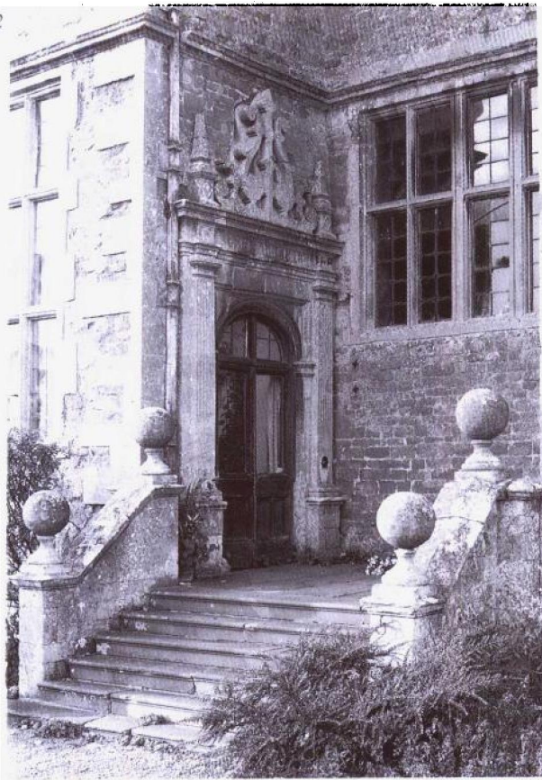
③ 室外的装饰效果可以通过各种方式来获得，这是 15 世纪末期多塞特的帕德尔敦的一座住宅，它有交替出现的碎缝石和石块砌
