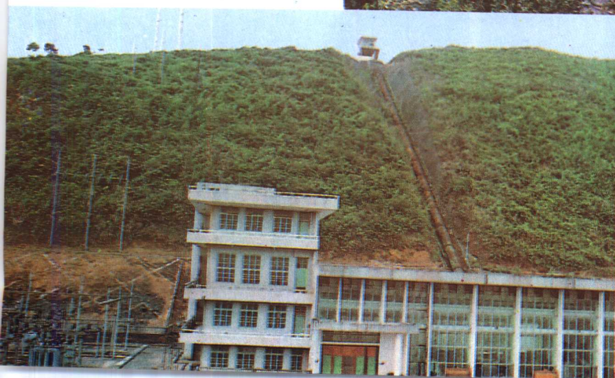
江口水力发电站
