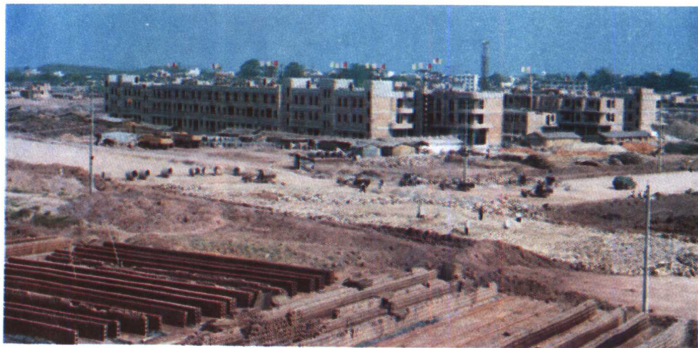
东兴开发区正在铺设新街道
