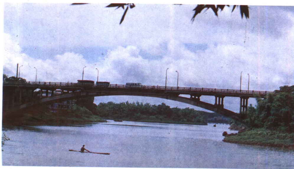
防城江大桥(一桥)
