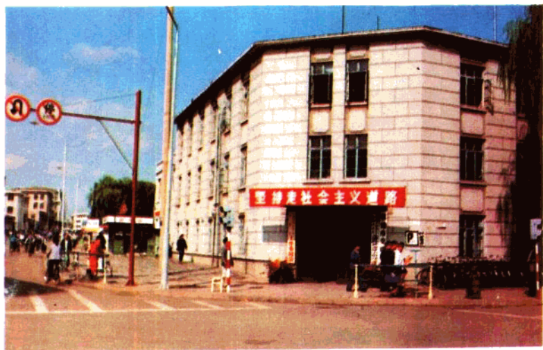
交 通 局 办 公 楼
