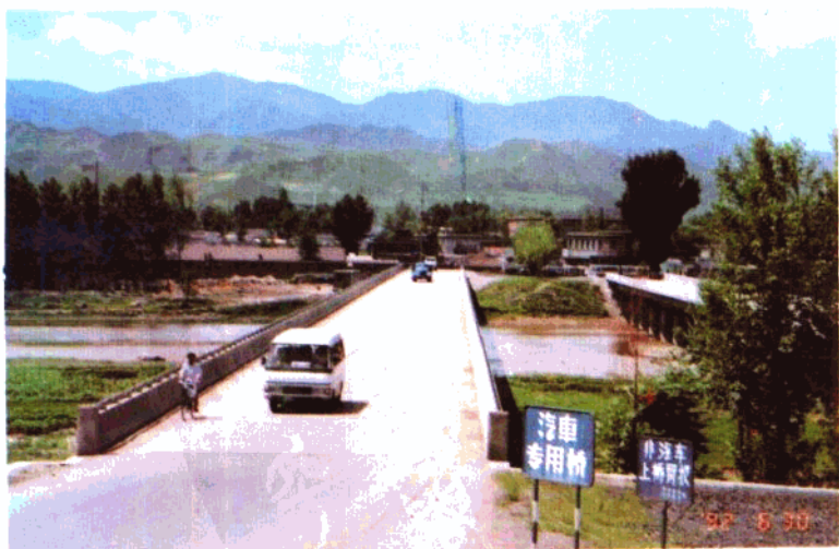
新建滦河公路大桥
