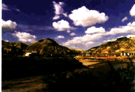
▲ 甘谷驿矿区全景
