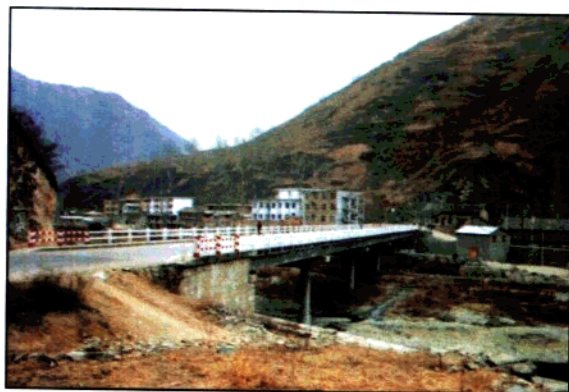
柞水商柞公路桃园乾佑河大桥
