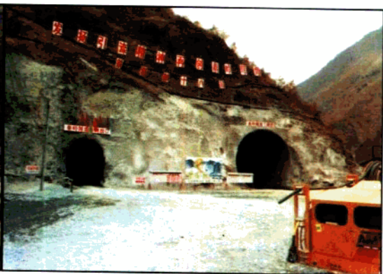
正在施工的西康铁路柞水秦岭隧道
