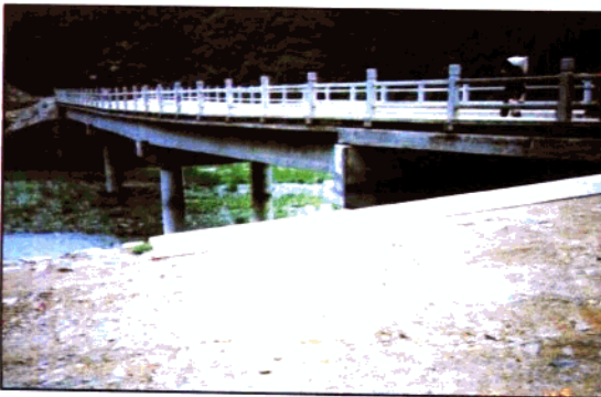
柞水商柞公路小河口大桥
