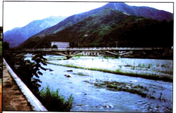
柞水下梁乾佑河公路大桥
