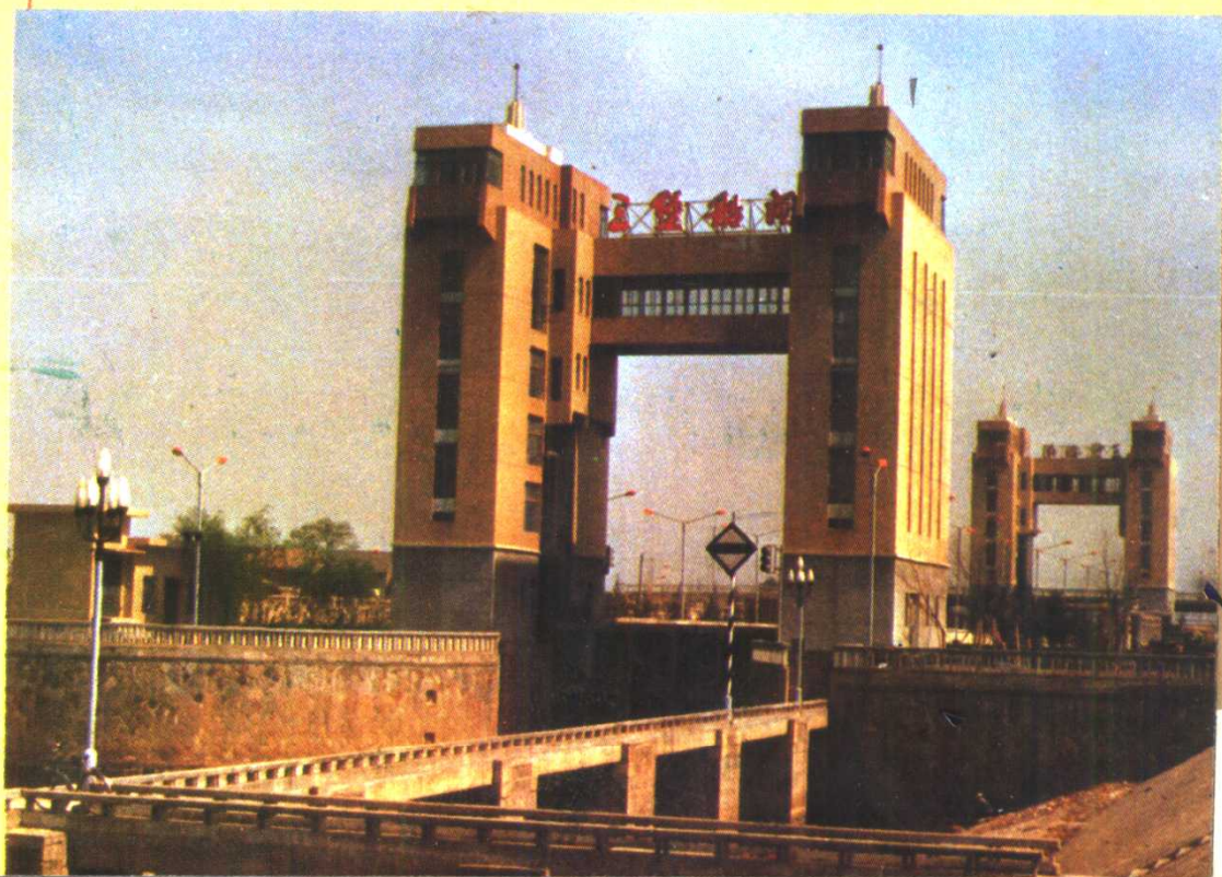
京杭大运河钱塘江入海口 ——杭州三堡船闸
