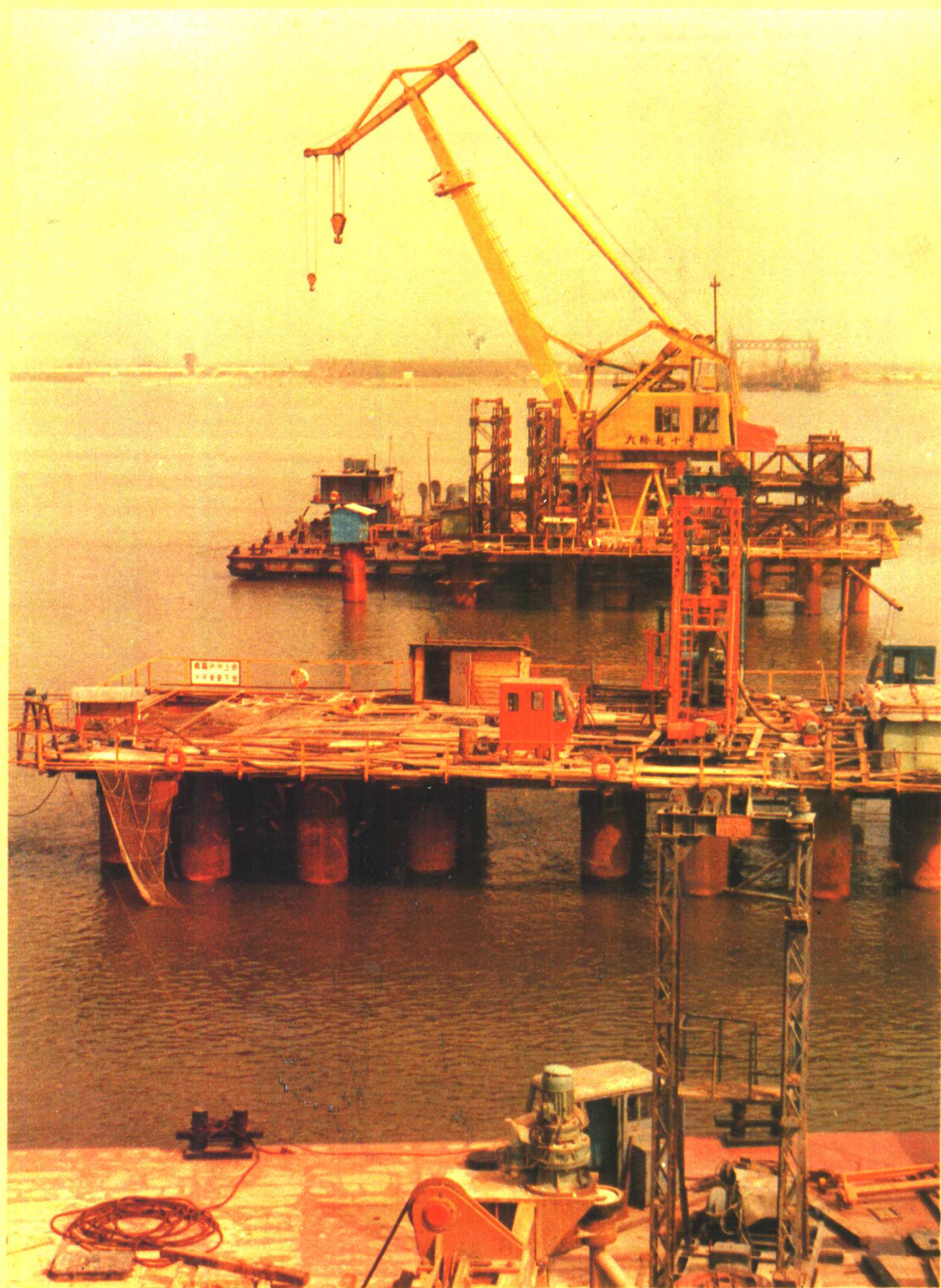
钱塘江第二大桥在建设中
