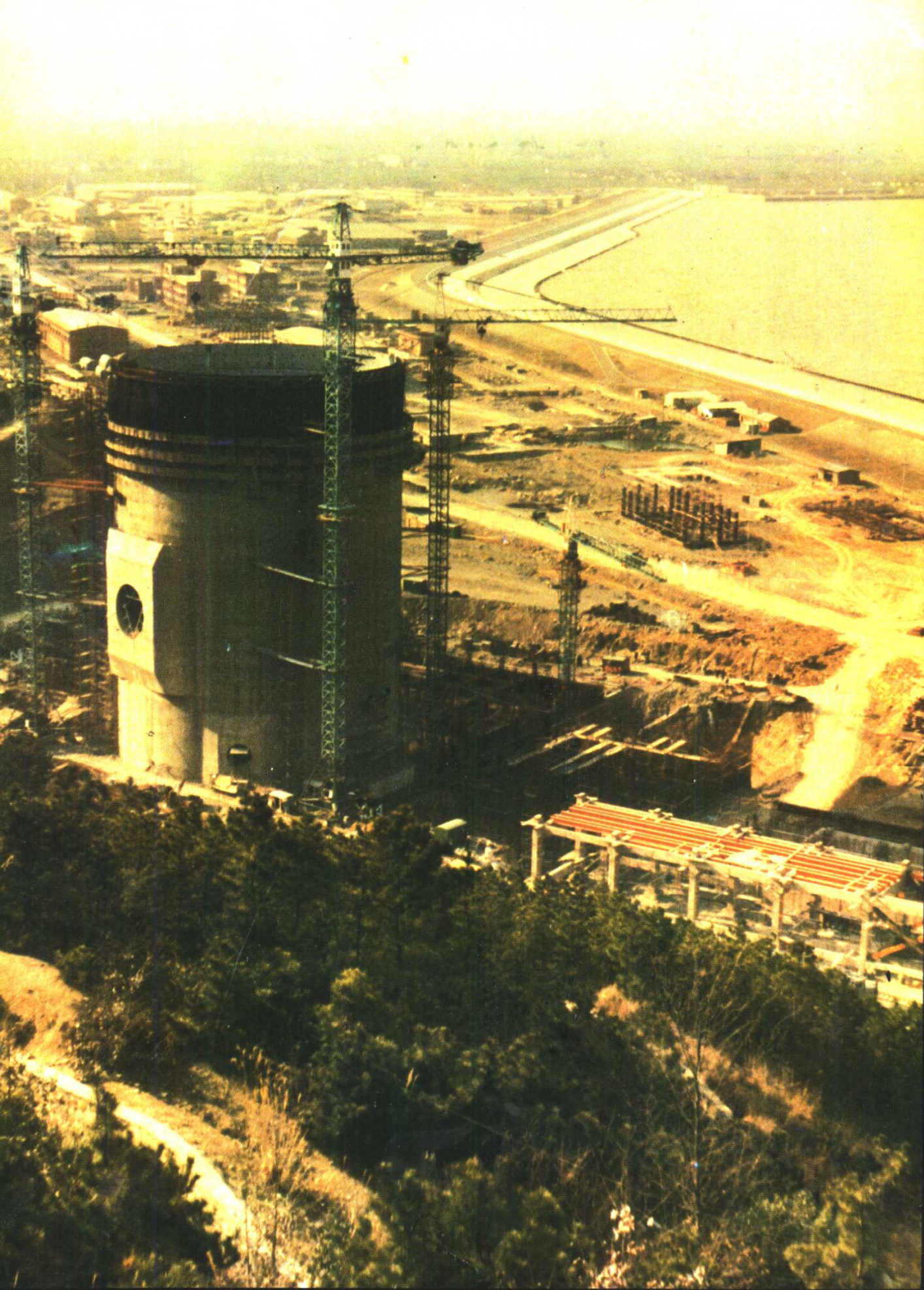
建设中的我国首座核电厂——秦山核电厂
