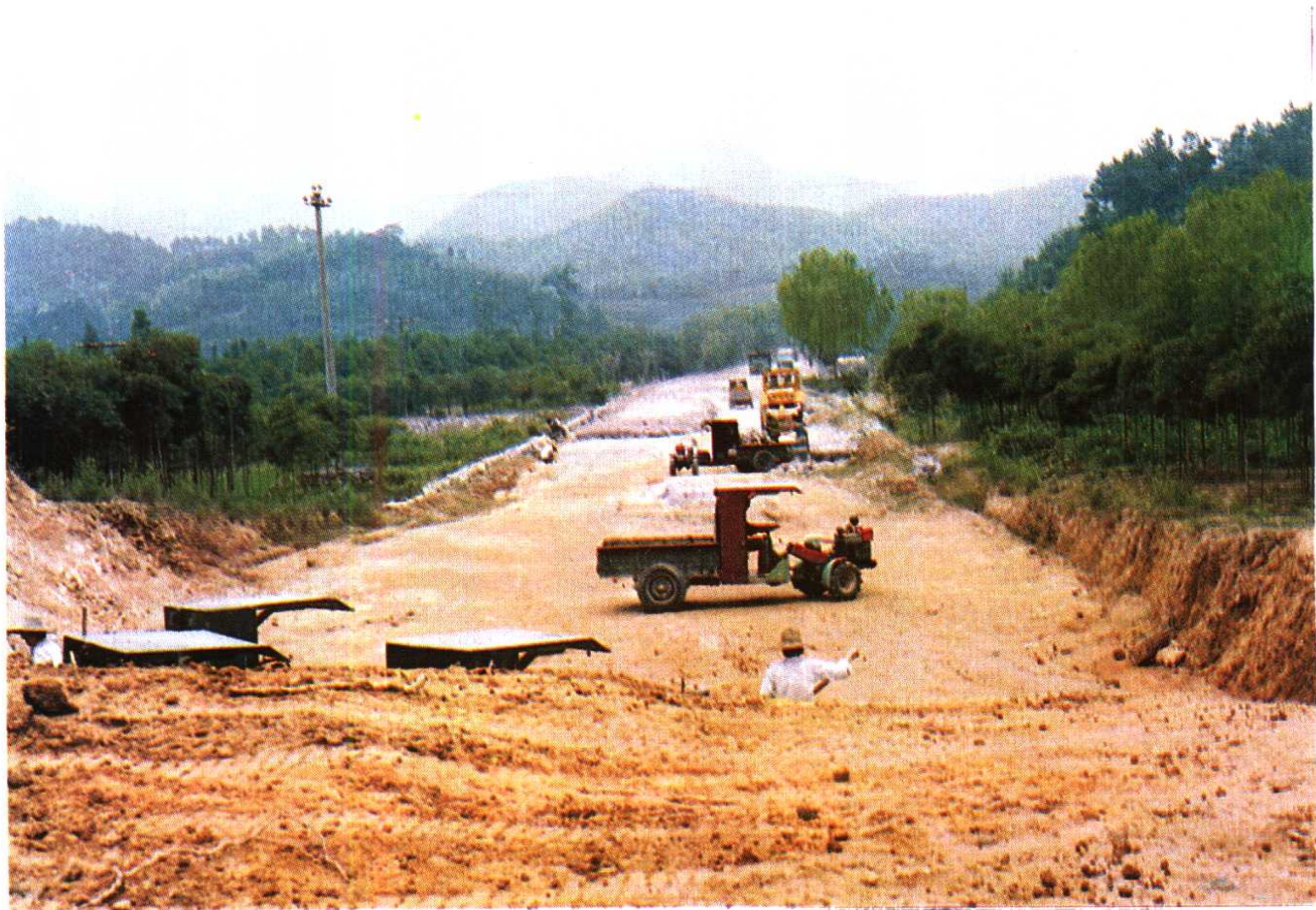
104国道水泥路面工程——上柏段施工
