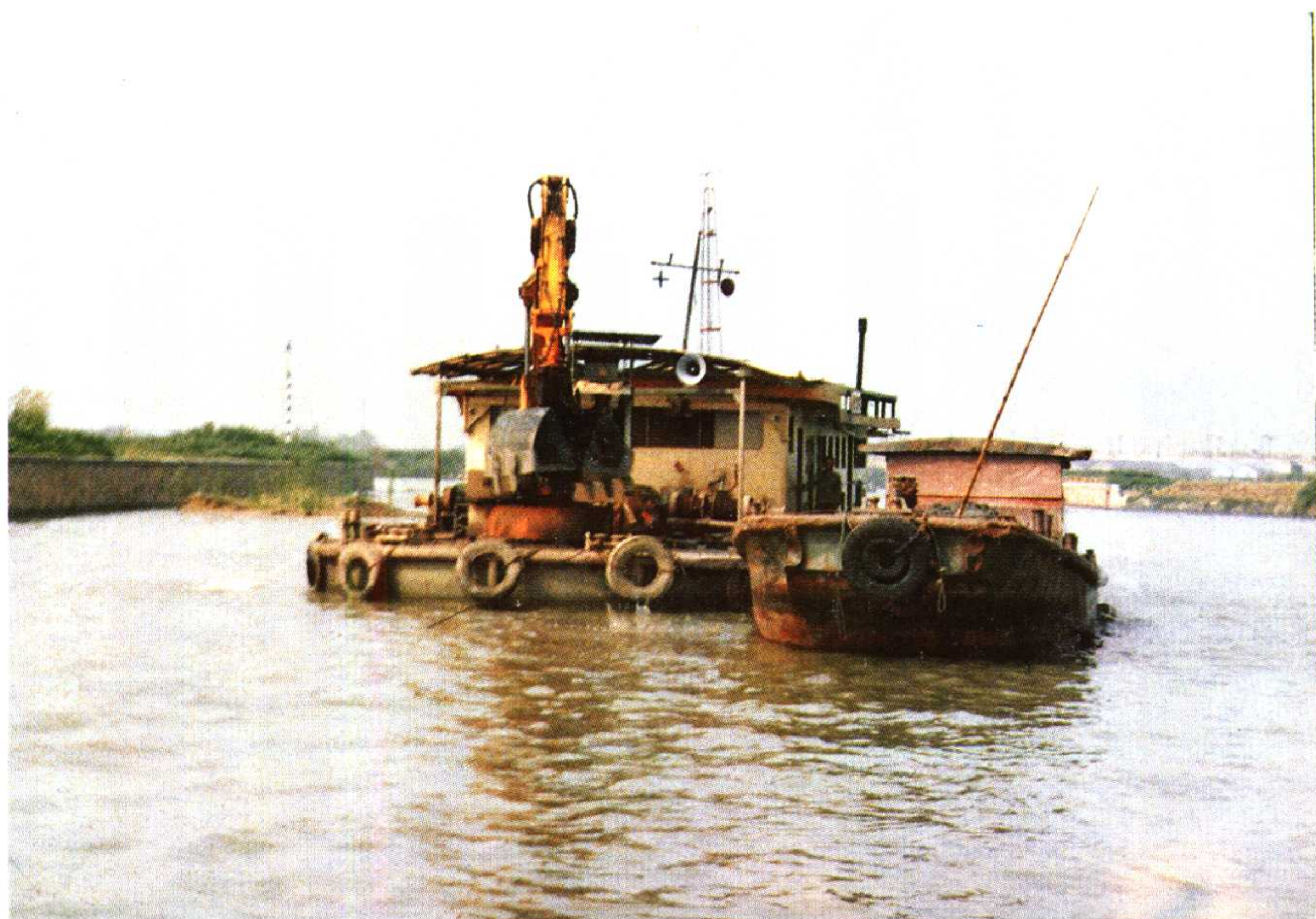
运河中线新市段在疏浚中
