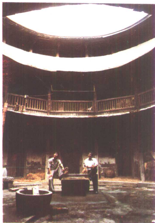
漳浦县深土乡三环 式金字塔形圆土楼 锦江楼的核心天井
