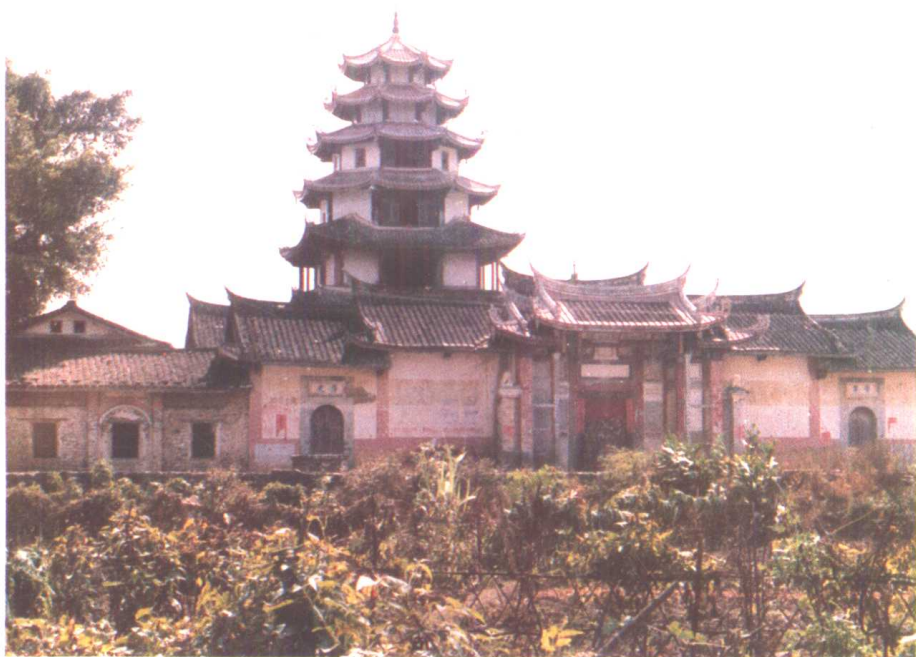
永定西坡天后宫夯土楼塔
