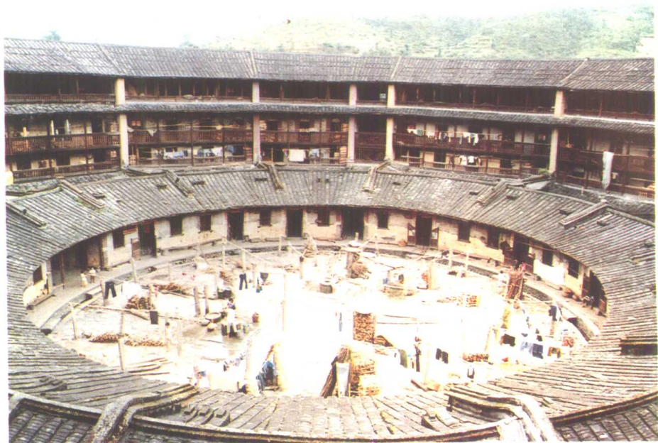
华安县仙都乡大型圆土楼二宜楼内景
