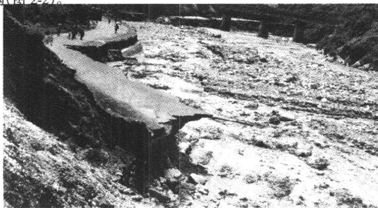
图 2-2 泥石流对道路的毁坏
