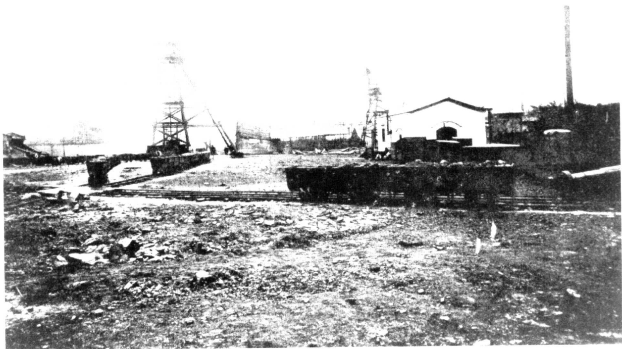
1922年建成的四亩墩二号新立井
