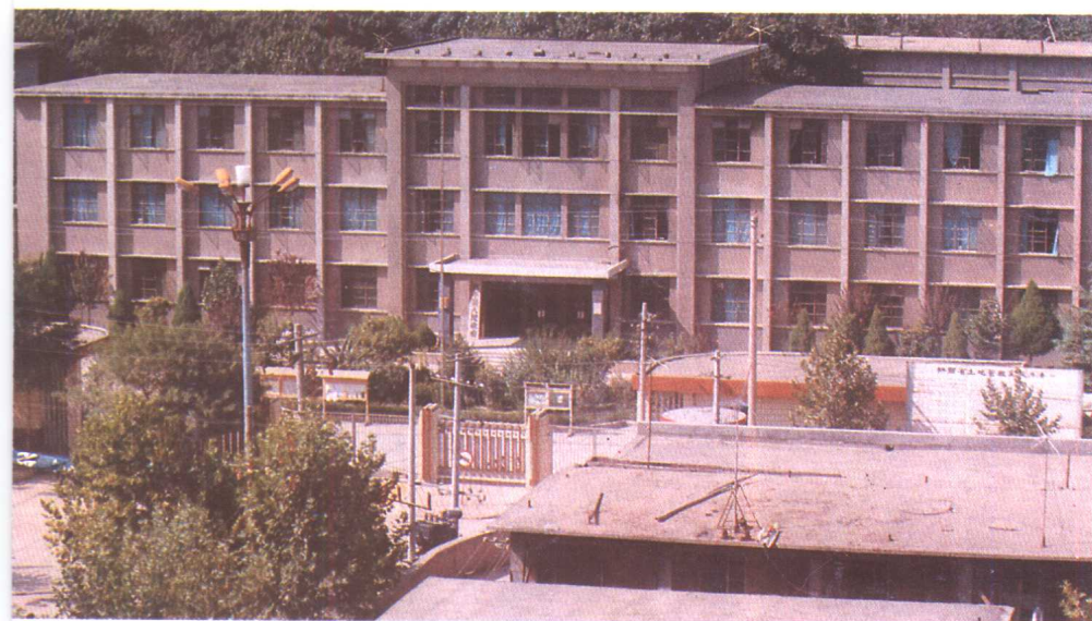
富平县人民政府办公大楼
