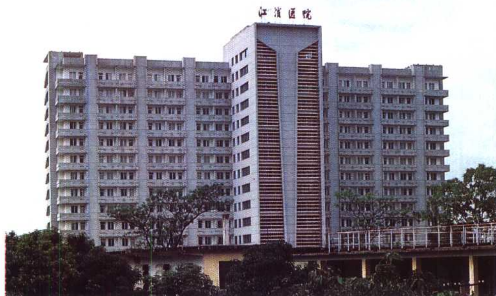
自治区江滨医院 住院大楼。
