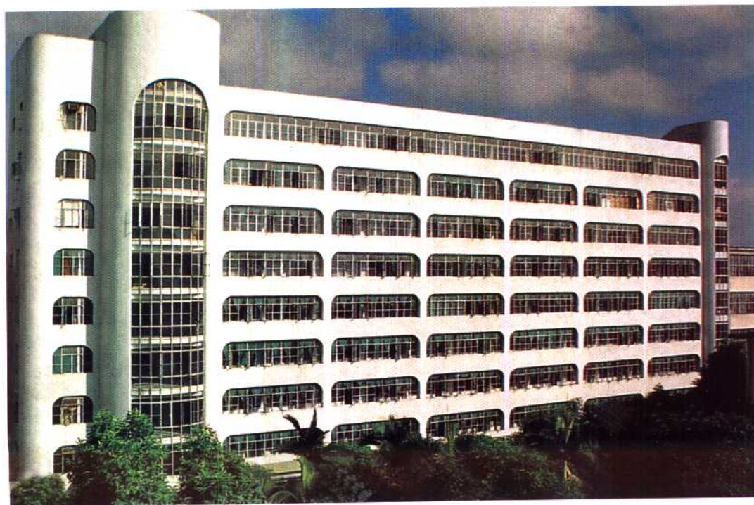
自治区卫生防疫站防病实验大楼。
