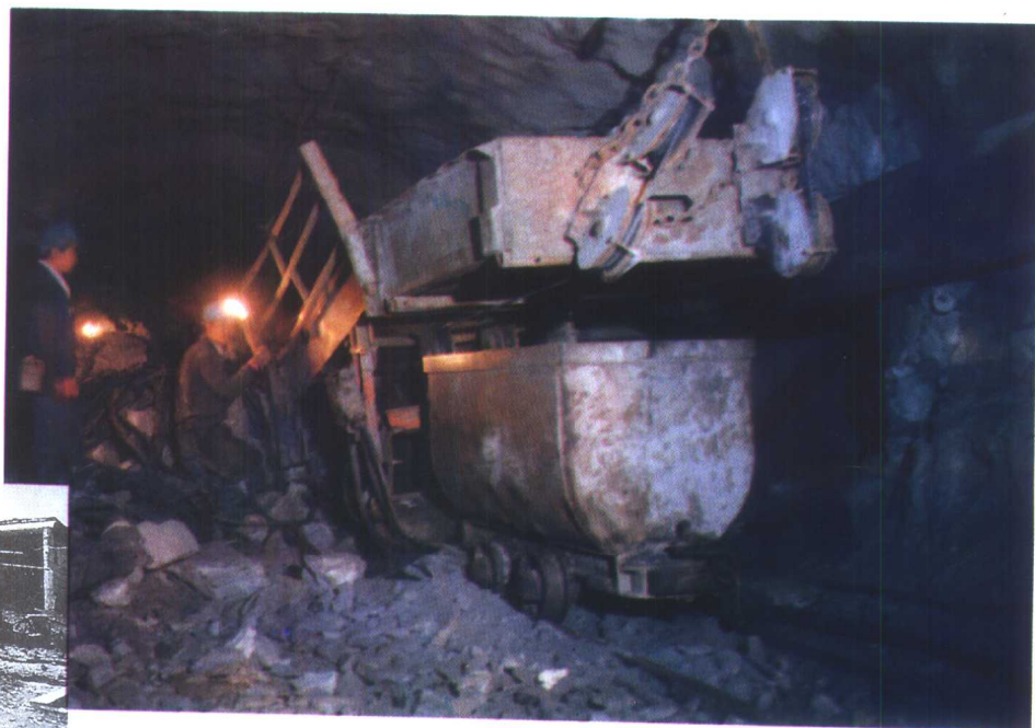
井下掘进巷道
