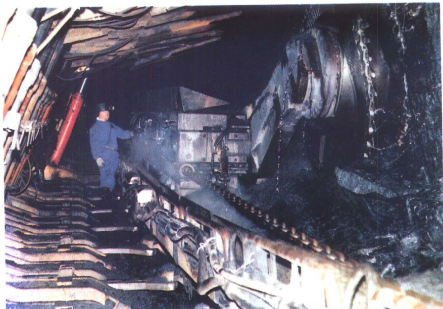
综合机械化采煤工作面
