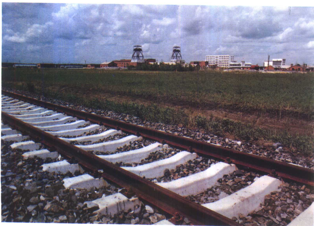
矿区自营铁路
