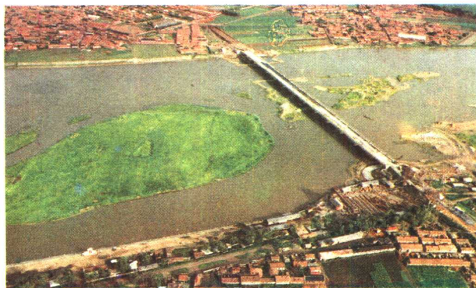
▲牡丹江新桥正在建设中
