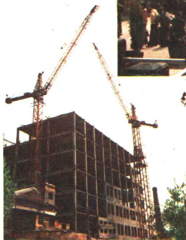
▲兴建中的电报大楼
