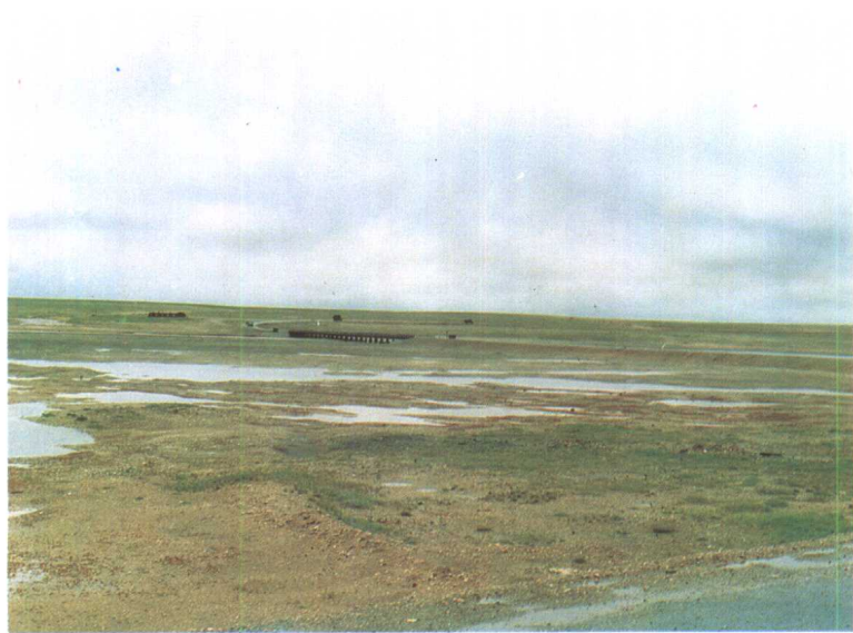
楚玛尔河青藏公路桥
