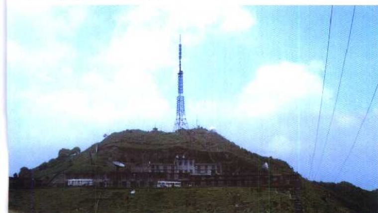
▼ 1983年1月1日建成的容山电视调频转播台, 海拔高度1275米, 设10千瓦电视发射机转播广西电视台节目, 覆盖人口983.16万人; 1988年4月1日设10千瓦调频发射转播广西人民广播电台节目, 覆盖人口1000万人。
