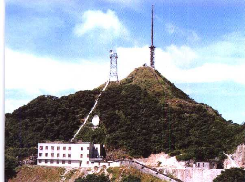
▲ 大明山(236)电视调频转播台的微波楼和广播电视发射铁塔, 1972年7月建成使用, 铁塔高48米, 覆盖面积3万平方公里, 海拔高度1507米。
